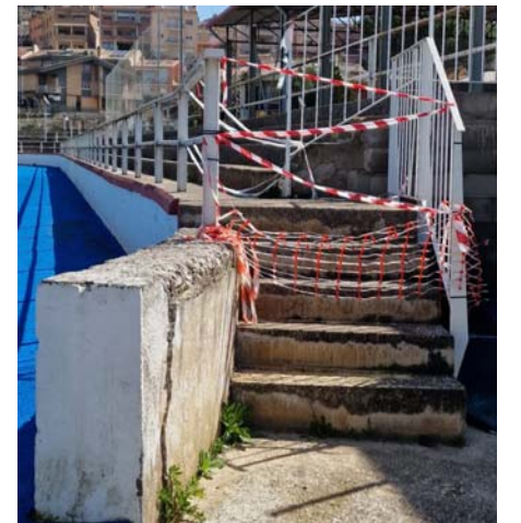
IMATGE GRADES EXISTENTS
