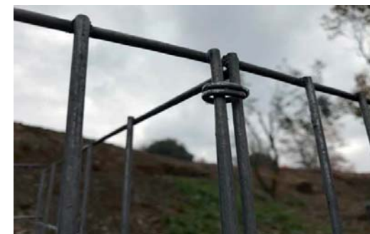
Detalle de los dos sistemas de unión de enrejados.
