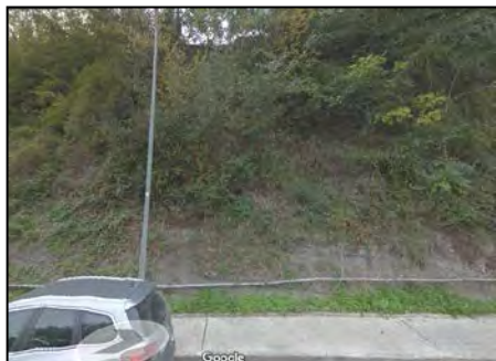
Foto. Vista parcial de on està prevista la futura instal·lació de l'ascensor.
