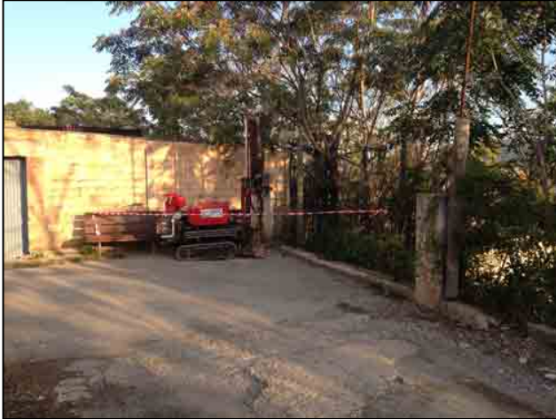
Foto 1. Treballs de realització del sondeig P1 al carrer de la Concepció
