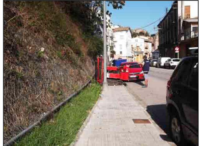
Foto 2. Treballs de realització del sondeig P2 al carrer de l'Estació
