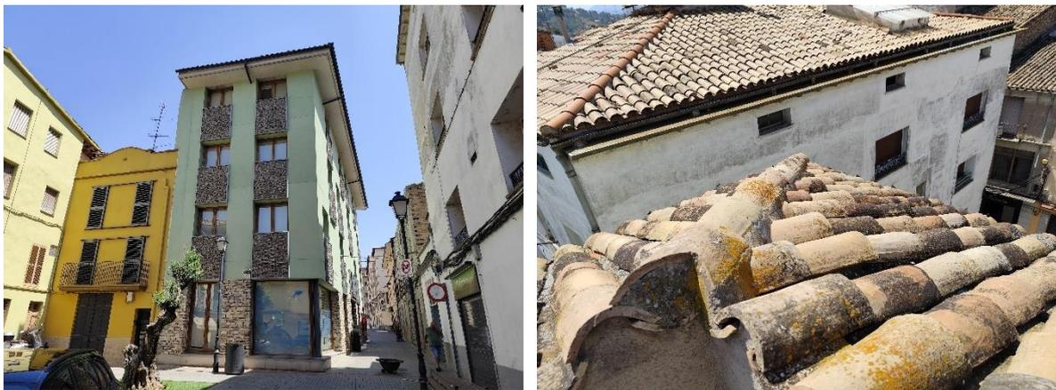
Les zones de la coberta on es projecta instal·lar els mòduls fotovoltaics no disposa de baranes ni mesures de seguretat anticaigudes. Per aquest motiu serà necessari instal·lar una línia de vida per realitzar la instal·lació fotovoltaica, així com les tasques de manteniment, complint amb tots els criteris de seguretat. Per facilitar l'accés als punts més elevats de la coberta es disposarà una escala homologada per a tal propòsit.
