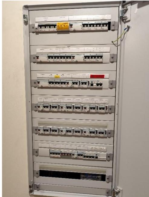
La instal·lació interior, que és on es connectarà la fotovoltaica, està protegida pel quadre general de comandament i protecció, el qual conté un ICP de 80 A i les proteccions de sobretensions, diferencials i magnetotèrmiques pels diferents circuits de l'edifici.
