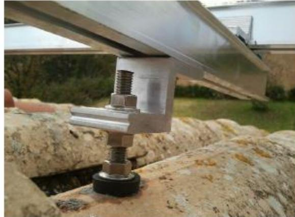
Les estructures de suport compliran la normativa vigent (CTE). S'han calculat per suportar les càrregues climatològiques adverses (neu i vent) segons el que estableix el DB-SE-AE, minimitzant així el manteniment.
