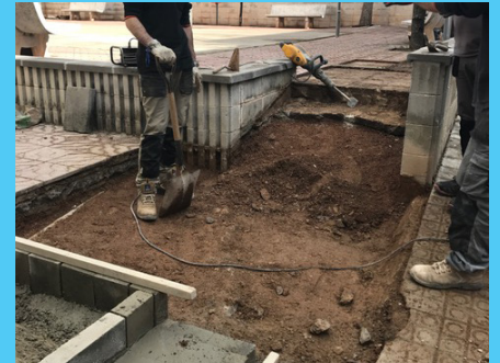
Obres a la Plaça Trenta-sisena
