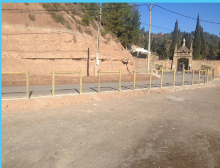
Millora accés al cementiri
