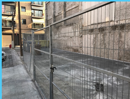
Demolició edifici Plaça Anselm Clavé
