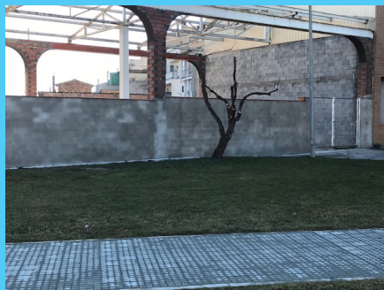
Tancat i sanejat antiga gasolinera
