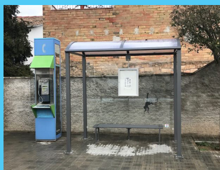
Instal·lació de marquesina
