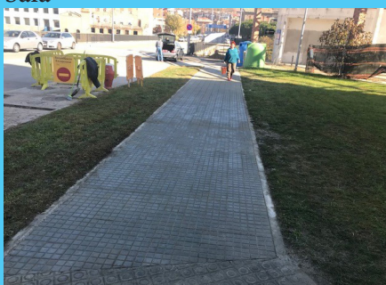
Arranjament voreres Pont Nou
