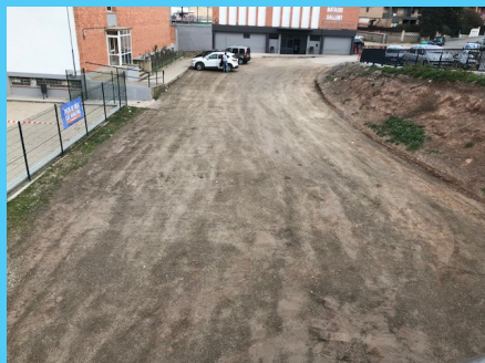
Arranjament aparcaments de la piscina, la muralla i la carretera.
