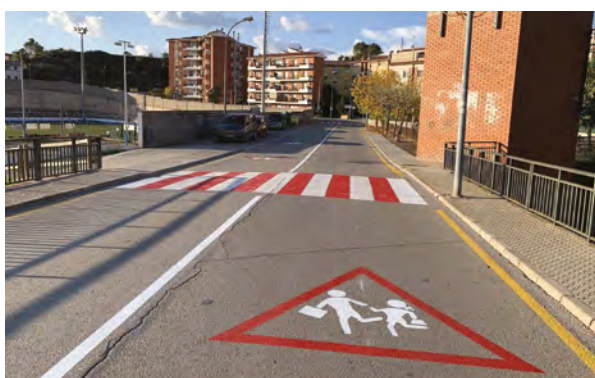
Millores als carrers Avinyó i Unió
